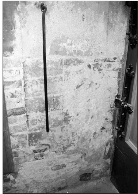
8. fotó: A tér felőli templombejárat rövid előterében az oldalfalon roncsolt formában de érzékelhető a korábbi lépcső lenyomata. A lelógó vasrúd mögött lapjával rakott téglák mutatják a korábbi ajtó asztalos- vagy kőszerkezetének egykori helyét
