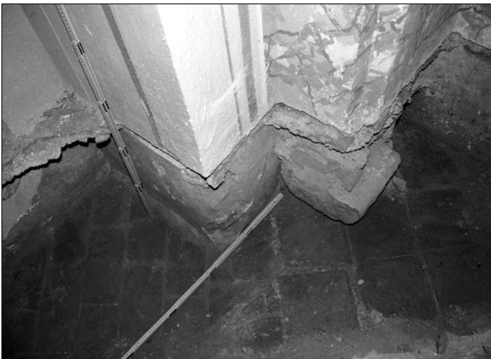
4. fotó: A falsarokban a Bucher-féle festéssel díszített tagolt karzatpillér alatt előkerült a korábbi, a kelheimi burkolat hordására kialakított téglapadló. Jól látszik, hogy a későbbi pillért úgy alakították ki, hogy azt részben a korai padlóra helyezett faragott kövekre alapozták (a fek-vő mérőlécc vége mutat a másodlagosan alapként felhasznált kövekre)
