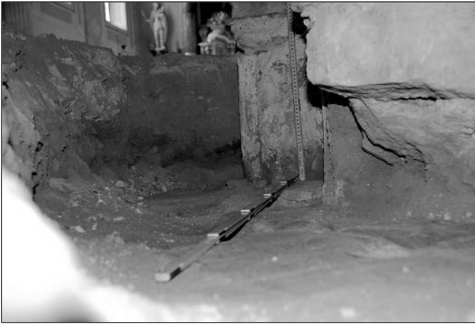
2. fotó: Az 1. fotón látható pillér oldalról. Egyrészt jól érzékelhető az alsó az egykori padló-vonalhoz tartozó vakolat, másrészt feltűnik a templom belső tere is és a vaskos feltöltés, amin a jelenlegi burkolat fekszik
