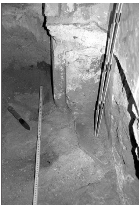
1. fotó: A XIX. századi járószint alatt feltárt barokk padló alapozási habarcsa (ezen fekszik az észak felé mutató spakni) és a kiugró pillér és fal sarkában megmaradt kelheimi burkolat töredéke (ezen áll a függőleges zollstock). Jól látszik a fotó felső részén a korábbi falsíkhöz képest előrébb ugró a szint emelés után kialakított fal, amelynek felszínén található a Franz Xaver Bucher által készített kifestés
