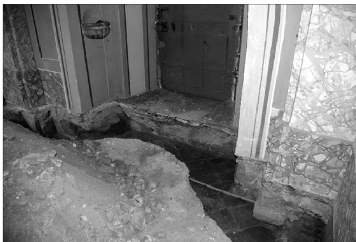
5. fotó: A karzat alól a kolostor folyosójára nyíló jelenlegi ajtó, amely alatt vakolt visszabontott fal került elő, jelezve, hogy itt korábban nem volt átjáró
