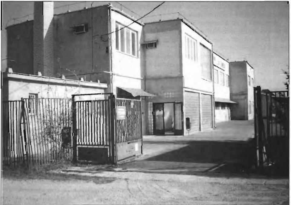
1996. A már megvásárolt moziüzemi épület, a felújítások előtt.
