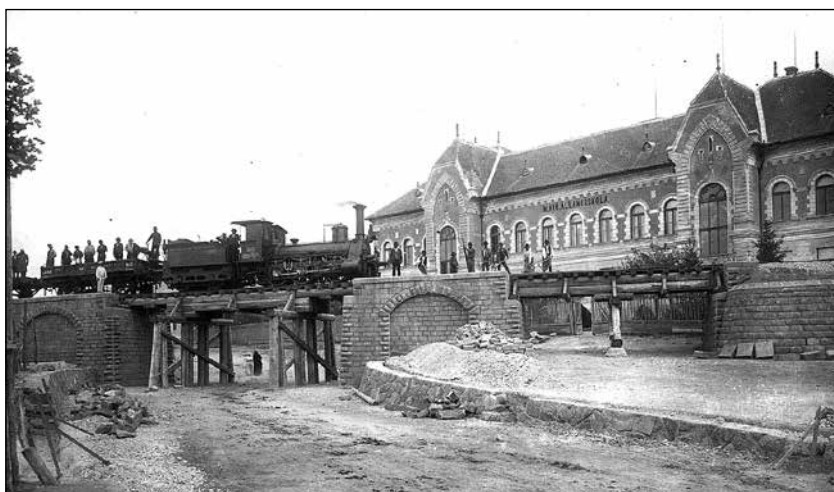
Veszprémi áthidalás a város felől nézve. A fotók forrása: Budapest Főváros Levéltára HU BFL XV.17.i.1 PM169/1-22 (A Szlovák Műszaki Múzeumban őrzött magyar vonatkozású tervek másolatainak gyűjteménye).
