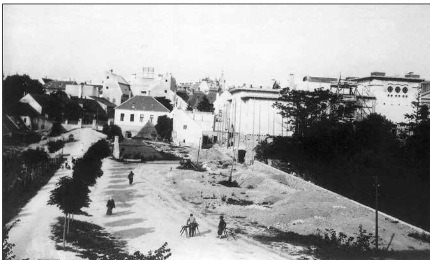
A színházépítés végső szakasza. Forrás: LDM Tf 2002.16.13
