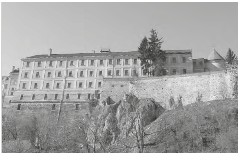
Iskolaépület a Buhim felől
