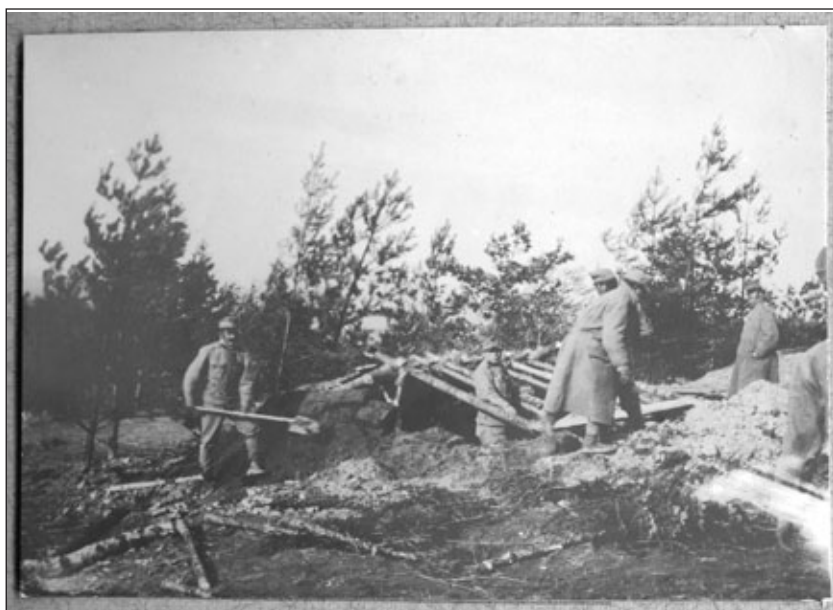
Védőállás Ryglicében A fedezékek építése közben
