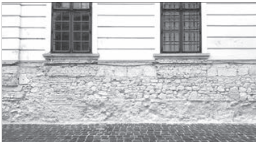
Déli homlokzat lábazata a másodlagos faragott kövekkel. (Fotó: G. Lászy Judit)
