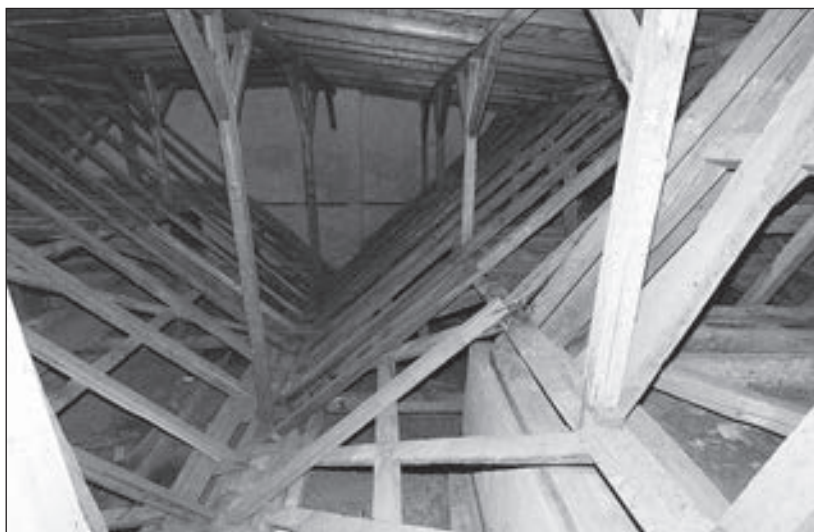
A manzárd fedésűvé átalakított két barokk ároktető csatlakozása. (Fotó: Hack Róbert)
