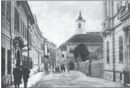
10. A Vár utca a gimnáziumnál, a D-i szárny felépítése előtt, a földszintes épületek bontása közben 1900-1902 körül. 53
