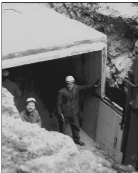
Az épülő közműalagút
