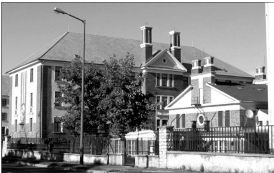
A Gazdasági épület utcai homlokzata
