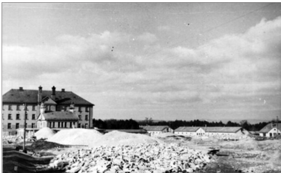
A II. sz. növendéki épület alapozásának előkészítése
