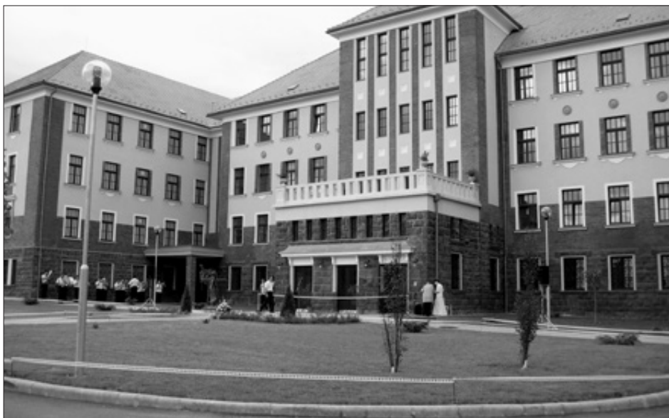
A felújított növendéki épület udvari homokzata
