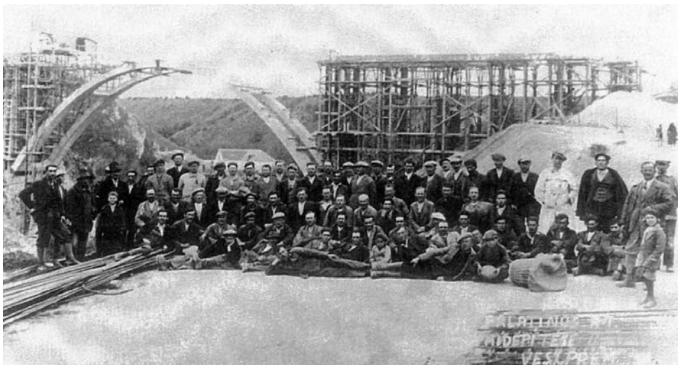
A veszprémi Viadukt építése. A csoportképen édesapám is látható.
