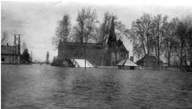
Az 1956 márciusi jeges ár Püspökpusztán. A kép bal oldalán a volt általános iskolám, középen a Ferenc-csatorna híd maradványa és a hidőrház teteje.
