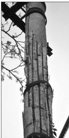
Betonkorróziós károsodások az oszlopon
