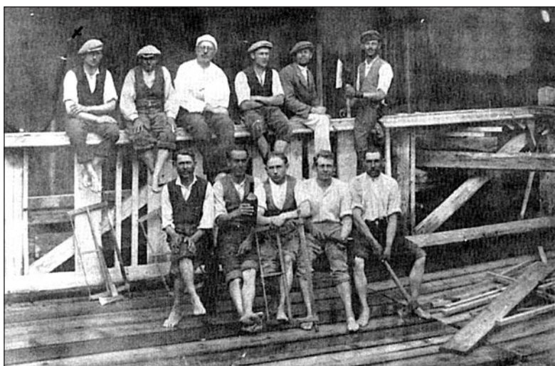
Csoportkép a Viadukt ácsolatát készítő ácsokról. (Bal szélén a felső sorban Debrecezyi Lajos ácsmester). Forrás: Debrecezyi családi albumból
