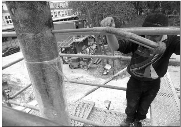
Az oszlop üreg injektálása
