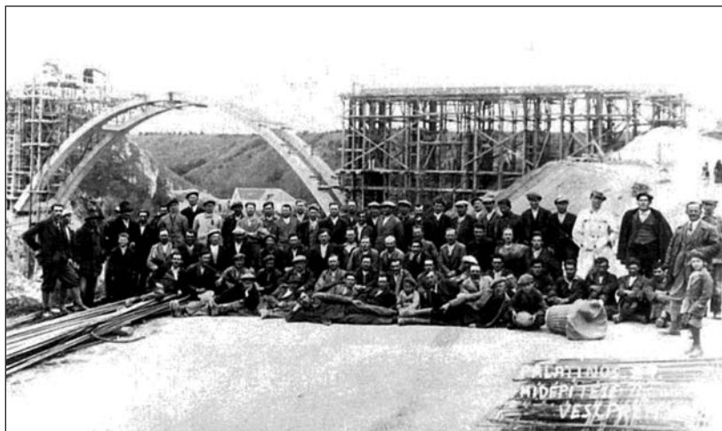
A Viadukt ácsolata a résztvevő munkásokkal, háttérben a Cukrász major. Forrás: Debreczeni–Zsebe családi album
