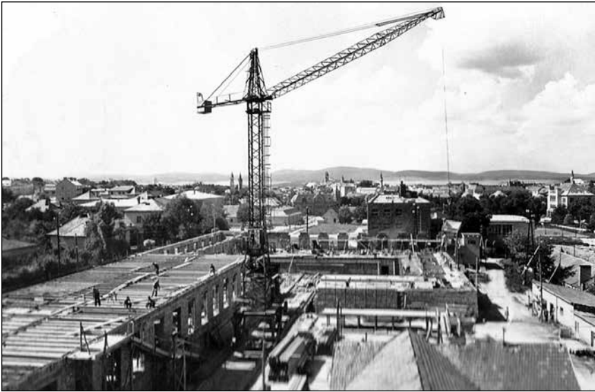
Zajlik az építkezés
